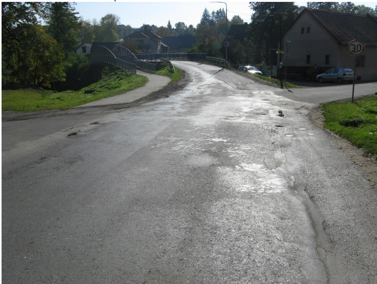
F02, km 0,410+ Vpravo vysprávky s deformacemi a výtlučky.
