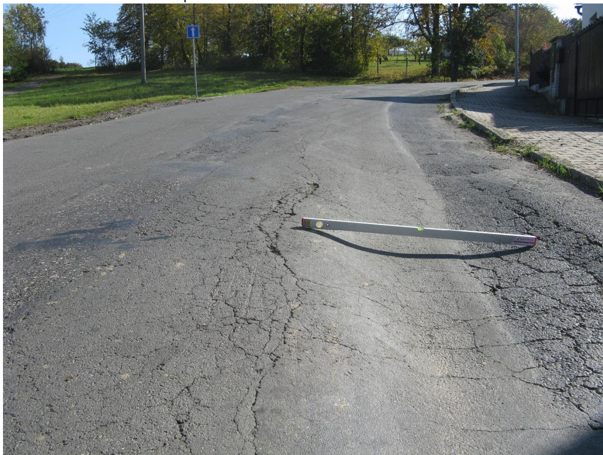
F11B, km 0,700+ Plošné deformace a síťové trhliny.
