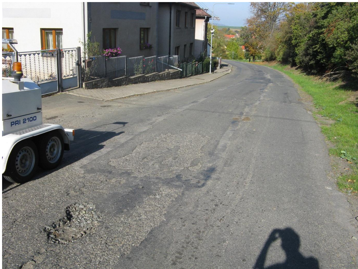
F18, km 0,840- Výtluk uprostřed a vysprávký okrajů s plošnými deformacemi.
