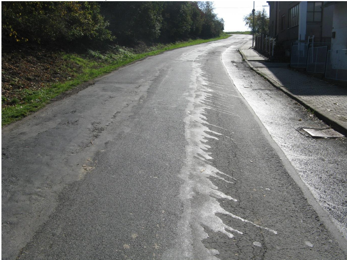
F15, km 0,760+ Zdeformované okraje - vpravo zapravená rýha, vlevo vyspráva okraje.
