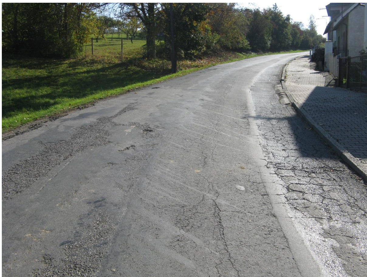
F13, km 0,720+ Vpravo zapravená rýha s plošnými deformacemi a síťovými trhlínami, zbývající vozovka s korozí a vysprávkami.
