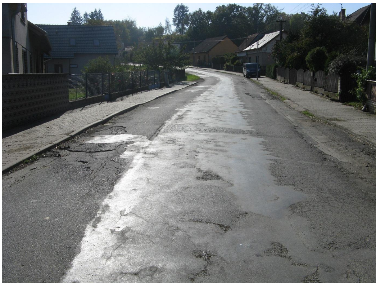
F05, km 0,510+ Po obou stranách zapravené rýhy, střed vozovky s vysprávkami a nepravidelnými hrboly a ztrátou makrotextury.
